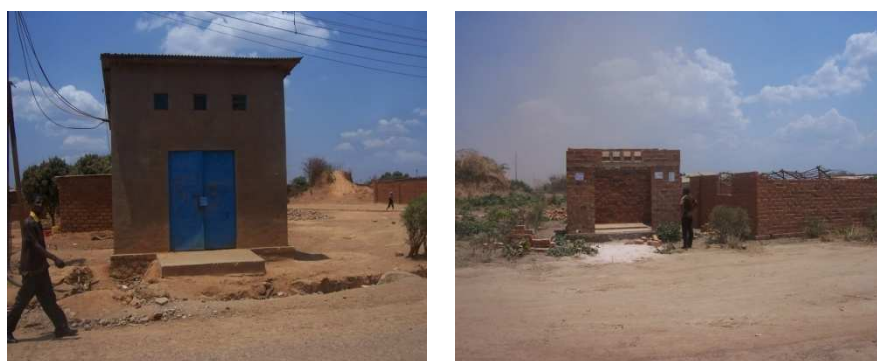
A gauche la cabine abritant le transformateur au quartier III de la RUSAHI et à droite, une cabine en construction vers l'entrée des installations de RUASHI MINING s.p.r.l. (photos PREMICONGO)
